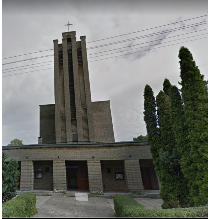
Zał. nr 1: Widok ogólny instalacji radiokomunikacyjnej.
