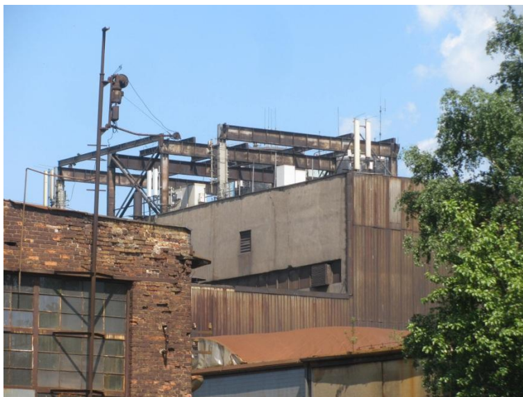
Zał. nr 1: Widok ogólny instalacji radiokomunikacyjnej.
