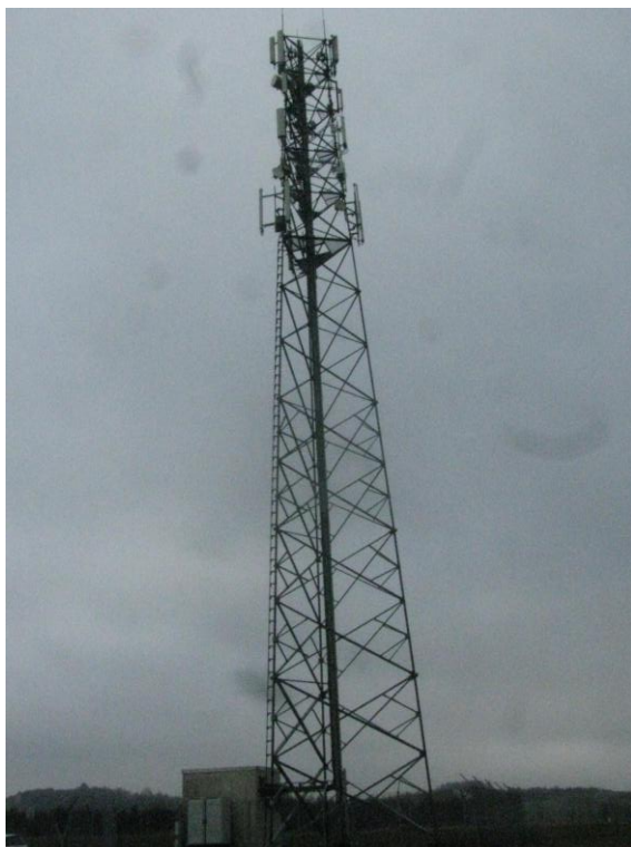
Zał. nr 1: Widok ogólny instalacji radiokomunikacyjnej.
