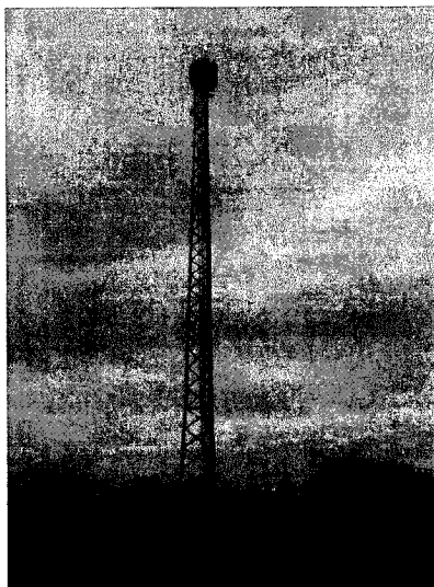
Widok obiektu wraz z zainstalowanym zespołem antenowym
