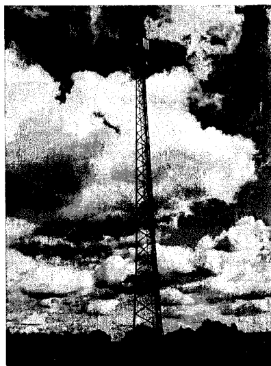
Widok obiektu wraz z zainstalowanym zespołem antenowym
