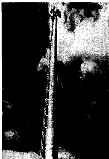
Widok obiektu wraz z zainstalowanym zespołem antenowym
